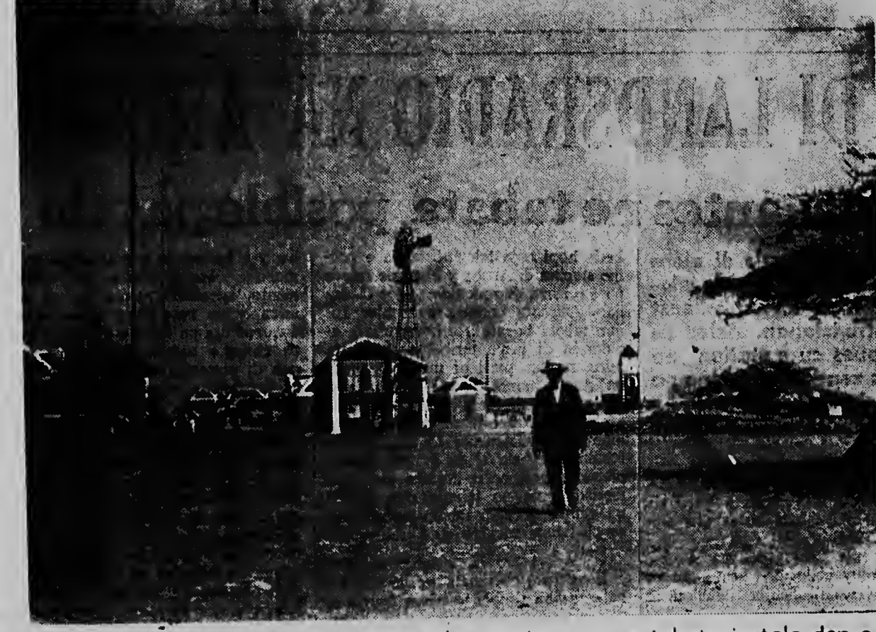
E radio station na Oranjestad tempo cu e la cumisa, y cu e tabata instala den e lugar caminda Gezondheidsdienst tabata despues. Cu molina e baterianan tabata worde carga, ora cu tin biento. Ora cu no tin biento cu un motor di auto Ford.
